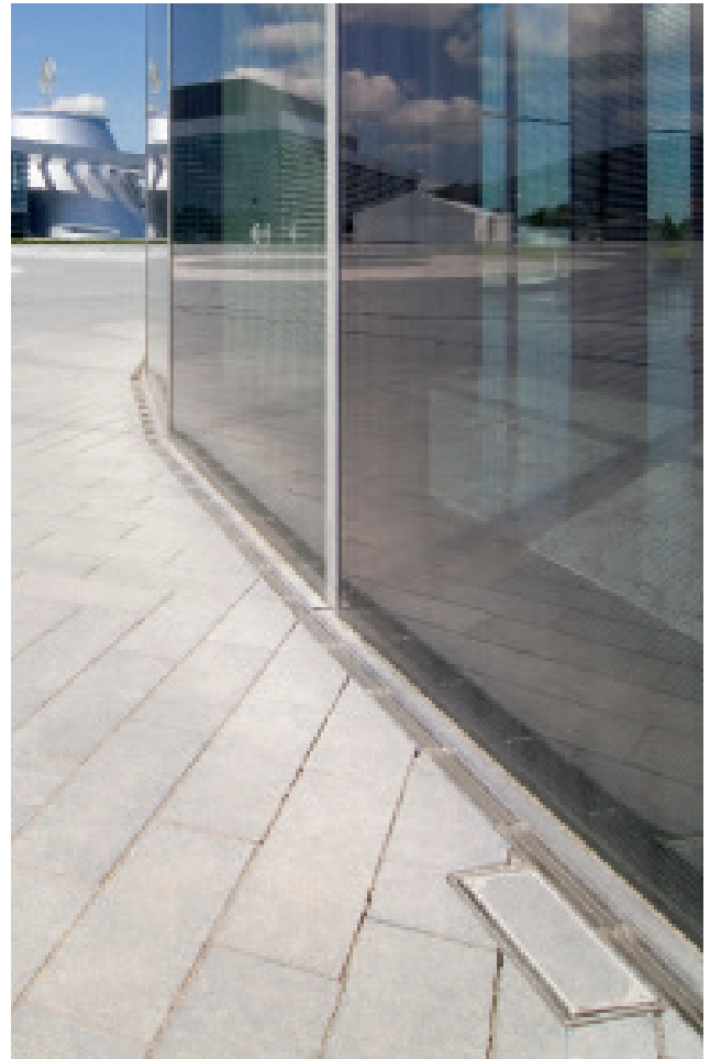
Le drainage de la façade est assuré par un caniveau doté d'une grille à barreaux longitudinaux et d'une paroi latérale amovible. Des trappes de visite spécifiques permettent un accès à la canalisation.
