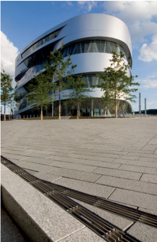
Les caniveaux de drainage en acier inoxydable ont été conçus individuellement et sur mesure conformément aux indications des architectes.
