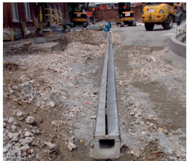
Pose du caniveau à fente avec un couvercle en acier inoxydable d'une épaisseur de 4 mm et une hauteur de gorge de 280 mm.
