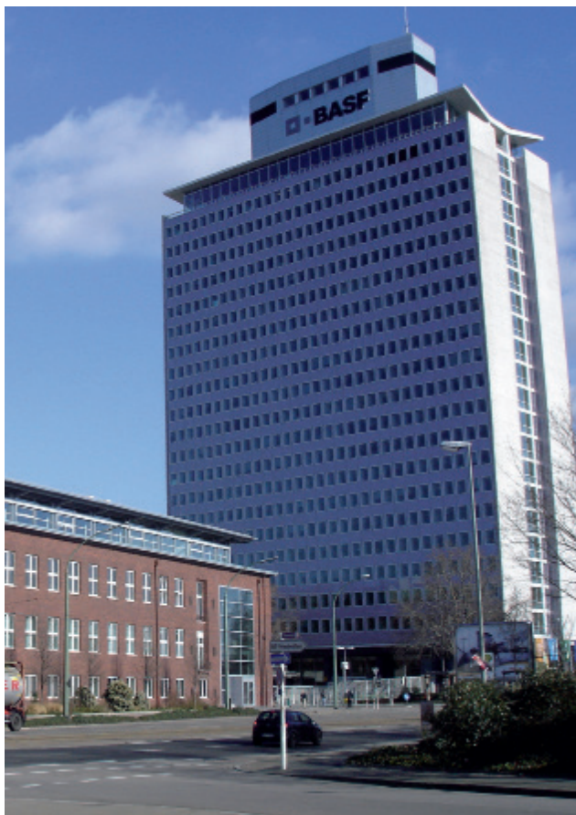
Le nouveau centre destiné aux visiteurs de BASF à Ludwigshafen.
