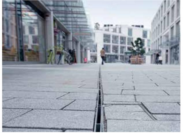
Flächenentwässerung mit maßgefertigten Schlitzrinnen.
